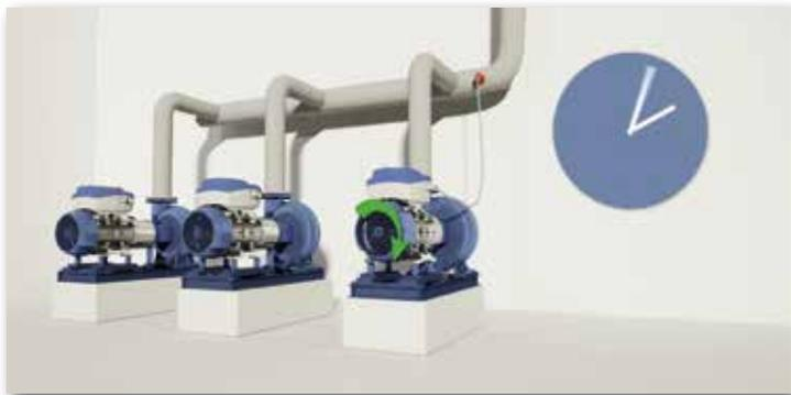
交替工作以最大化每个泵的使用寿命
