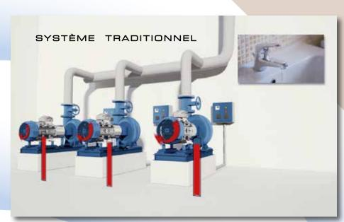
Tout système non équipé de variateur, consomme toujours la puissance maximale de l'ensemble des pompes, quel que soit le besoin réel en eau
